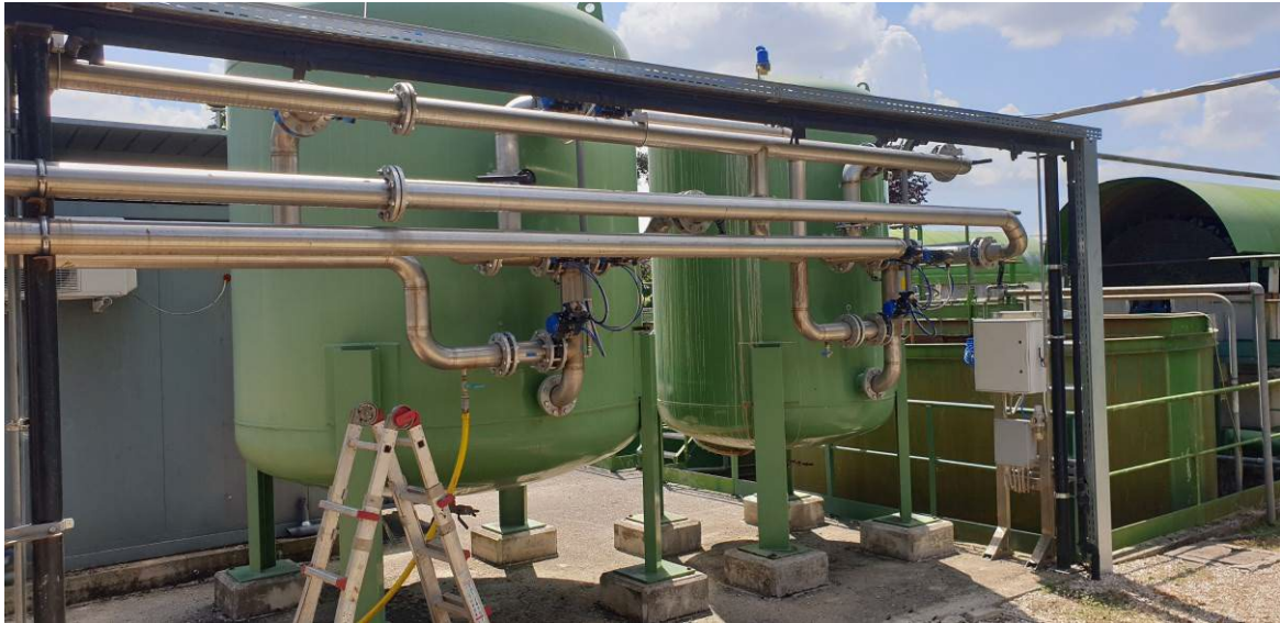
Figura 6. Filtri a sabbia e a carboni attivi
