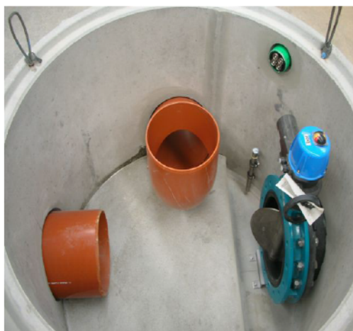
Deviatore con elettrosaracinesca e sensore
