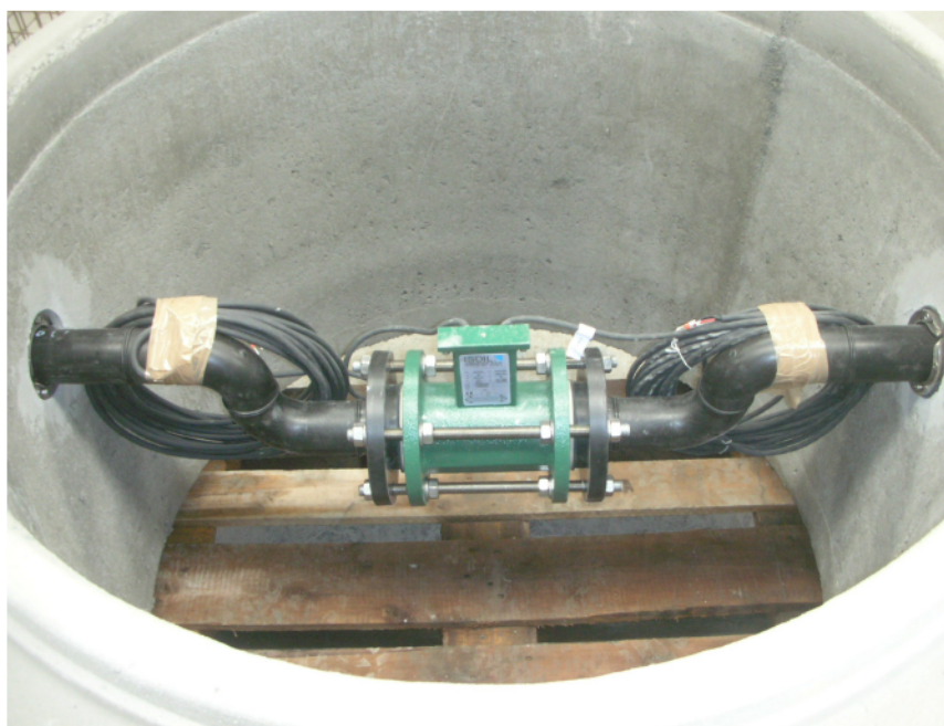
Fig.2 pozzetto con contatore NEUTRAcop
