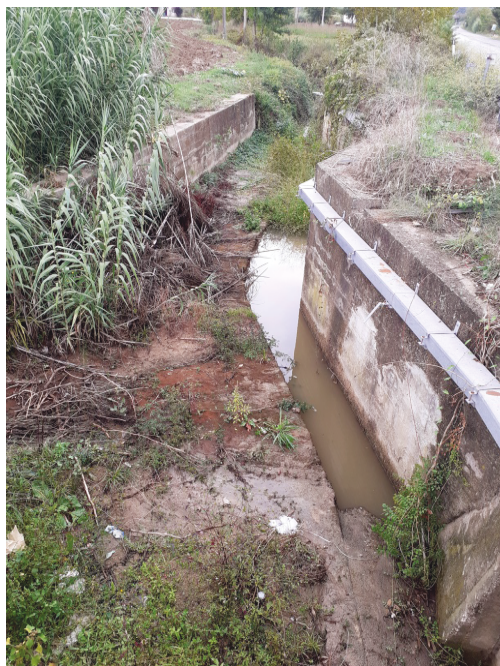
2. alveo del fosso nel tratto in esame; le sponde si presentano rivestite con pareti in conglomerato cementizio armato
