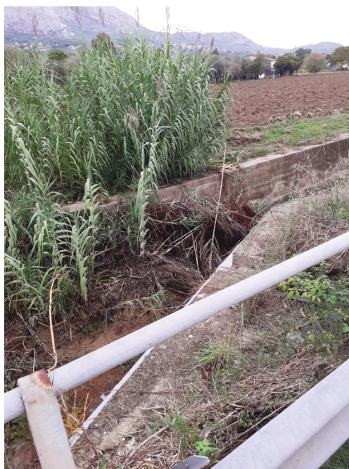
2. alveo del fosso nel tratto in esame; le sponde si presentano rivestite con pareti in conglomerato cementizio armato
