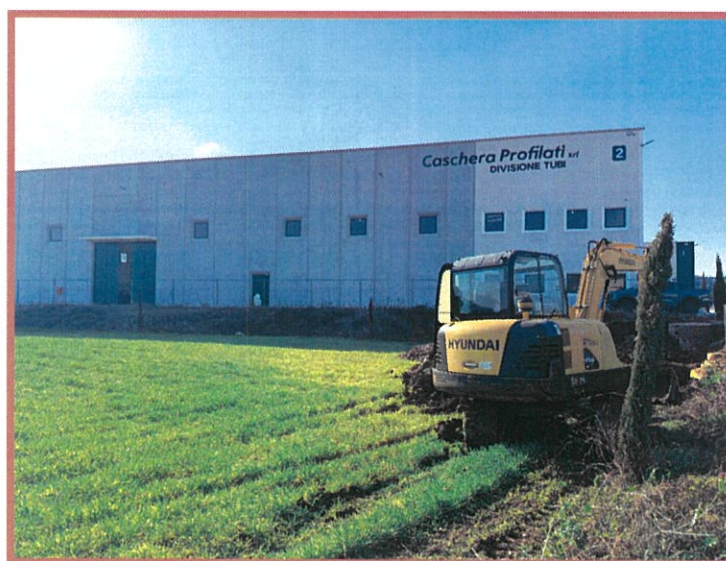
inizio lavori 11.12.2025 area oggetto di interventi
