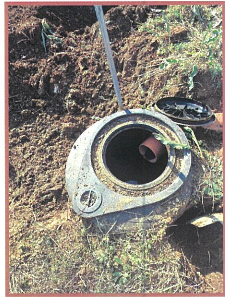
1. pozzetto scolmatore
