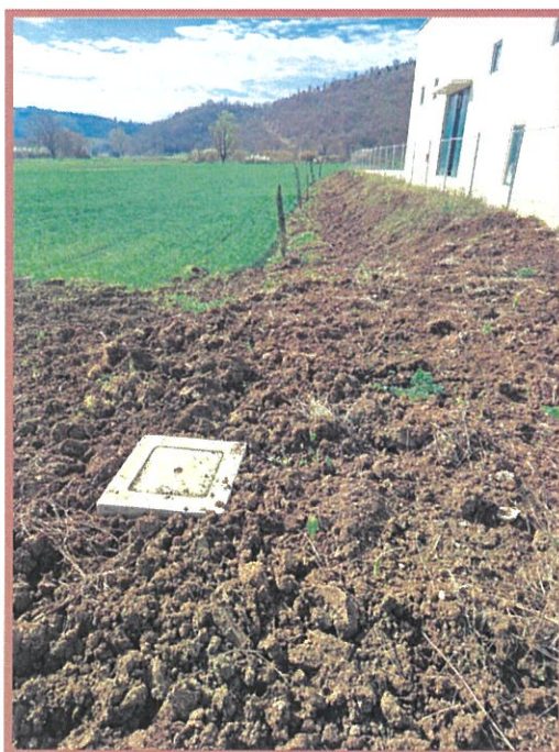
pozzetto confluenza acque nere provenienti dagli uffici e spogliatoi
