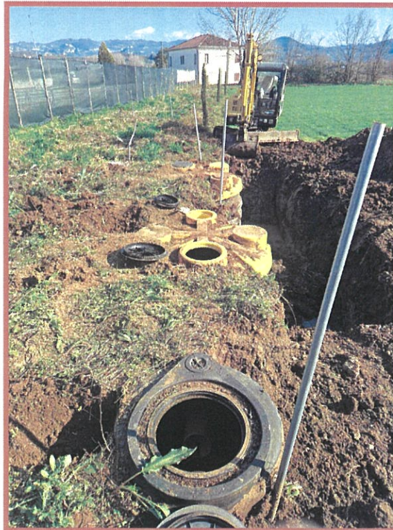
in sequenza a) pozzetto scolmatore b) dissabbiatore c) deoleatore
