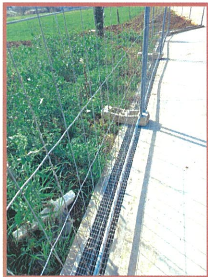
griglia di raccolta acque del piazzale
